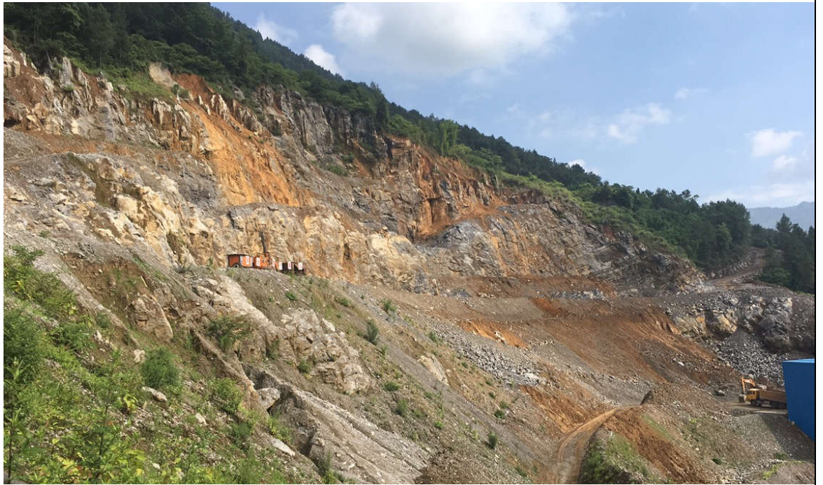
(附项目勘察相关图片)
